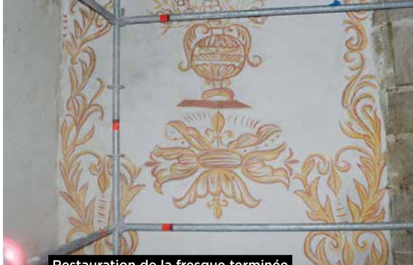
Restauration de la fresque terminée
