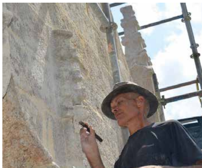
John le tailleur de pierre, répare les fleurons de la porte ouest en sculptant le mortier qu'il a ajouté
